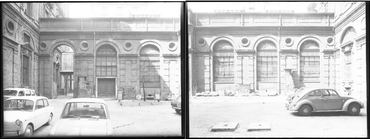
Figura 10 Facciata interna del palazzo del Collegio dei Nobili prima della realizzazione delle tamponature in vetro (1970 circa). Fonte: Archivio Fotografico del Museo Egizio.
